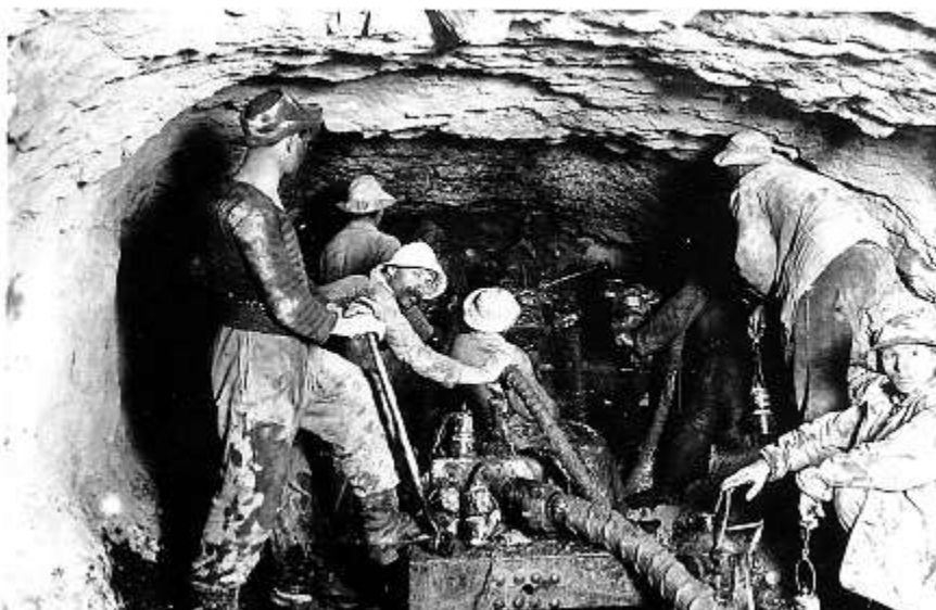
Vortrieb im Sohlenstollen. Foto: Stadtarchiv Grenchen.
