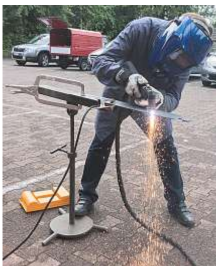
Mit dem Plasma-Schweissbrenner lässt sich Stahl schneiden. Foto: Robert Loosli.
